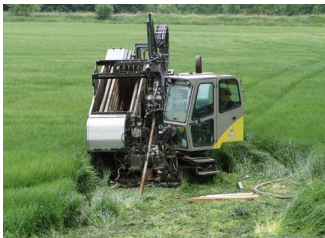
Pokládka vodovodního potrubí SafeTech RC d225 pro společnost Kofola a.s. v Krnově
