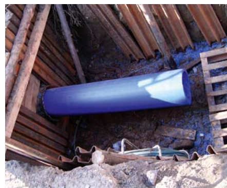
Sanace ocelového vodovodního přivaděče DN 400 v Chuchli vyřešila časté poruchy a zlepšila kvalitu pitné vody
