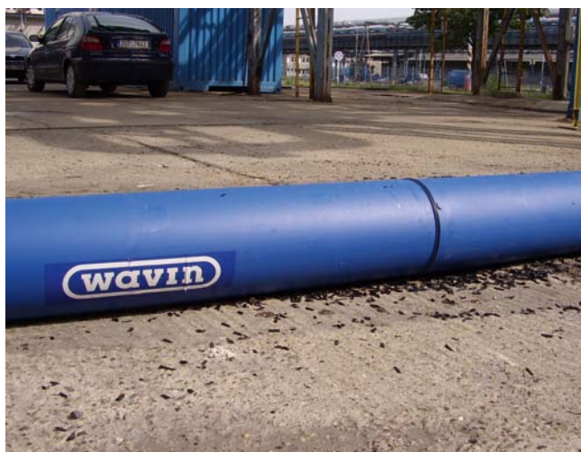
Sanace ocelového vodovodního potrubí DN 300 technologií Relining ve Štětí
