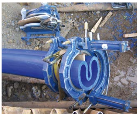
Sanace ocelového vodovodního přivaděče DN 400 v Chuchli vyřešila časté poruchy a zlepšila kvalitu pitné vody
