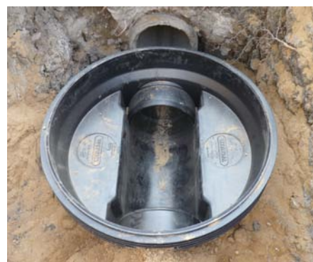
Sanace kanalizačního potrubí DN 300 a DN 400 v Praze Běchovicích probíhala současně s výměnou kanalizačních šachet
