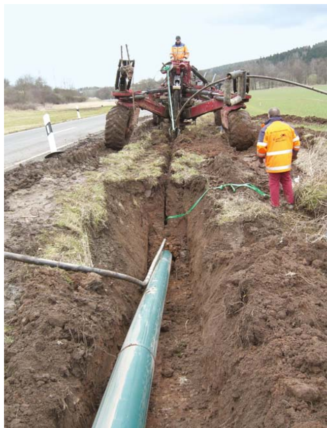
Pokládka kanalizačního výtlaku raketovým pluhováním
