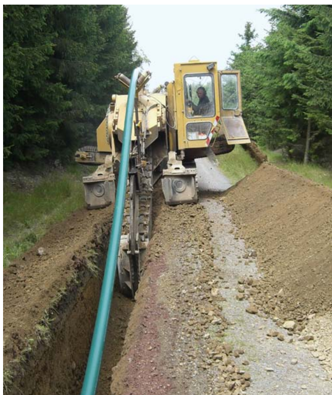
Pokládka kanalizačního potrubí SafeTech RC d140 mm a Wavin TS d140 frézováním v německém Friedrichsbrunn Harz a Strassberg Harz
