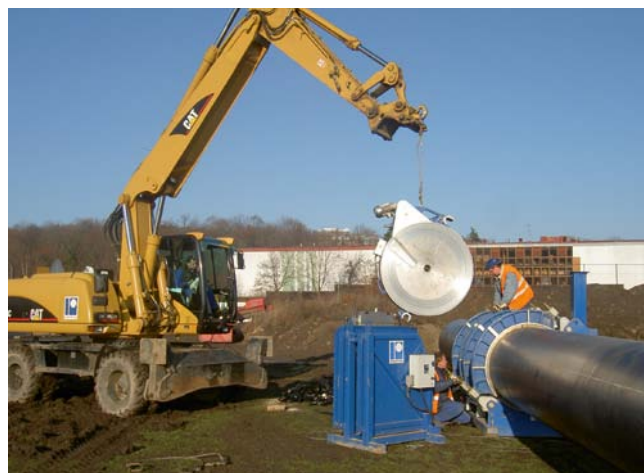
Sanace ocelového vodovodního přivaděče DN 800 v Chrudimi technologií Close-Fit (na stavbě)
