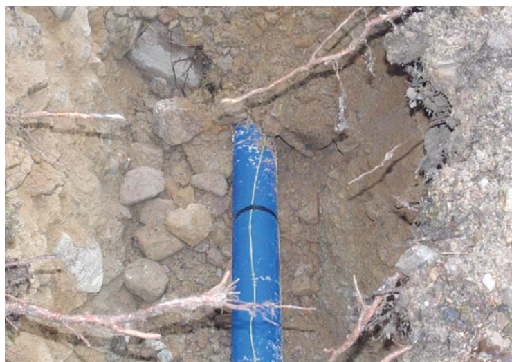
Schéma uložení potrubí bez pískového lože ve volném terénu
