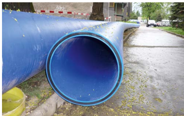
Sanace ocelo-litinového potrubí DN 400 technologií Berstlining v Koprivnici
