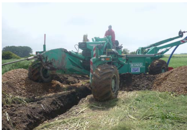
Pokládka vodovodu o průměru 110 mm pluhováním potrubí Wavin TS v Radslavicích
