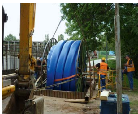
Sanace ocelového vodovodu DN 500 v centru na Prašném Mostě proběhla v extrémně krátké době do zprovoznění
