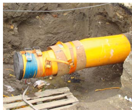
Sanace plynovodu DN 500 na ulici Nuselské proběhla za rušného provozu v těsné blízkosti tramvajového pásu
