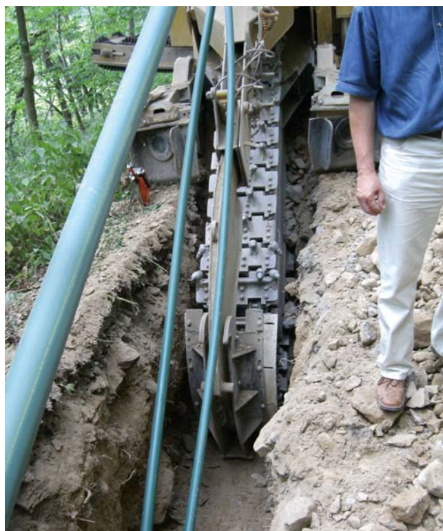
Pokládka kanalizačního potrubí SafeTech RC d140 mm a Wavin TS d140 frézováním v německém Friedrichsbrunn Harz a Strassberg Harz
