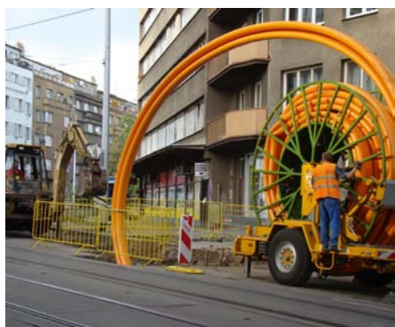
Sanace plynovodu DN 500 na ulici Nuselské proběhla za rušného provozu v těsné blízkosti tramvajového pásu
