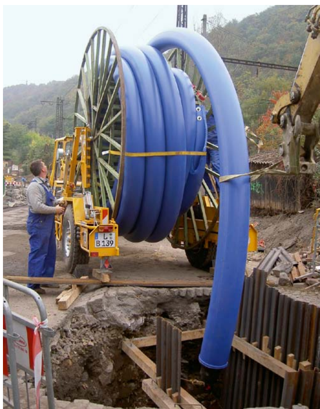
Sanace ocelového vodovodního přivaděče DN 400 v Praze Chuchli – Compact Pipe
