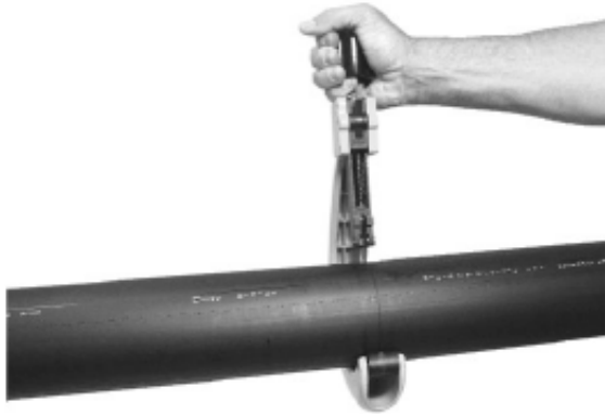
Obr. 3 – Řez potrubí rotační řezačkou
