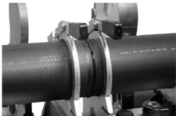
Obr. 6 – Chladnutí svařeného spoje
