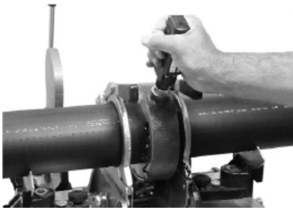
Obr. 4 – Srovnání konců potrubí hoblíkem
